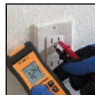
Tests GFCI** protected circuits
